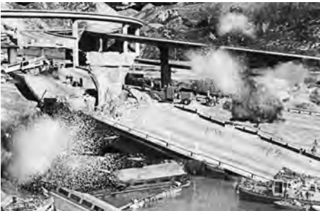
Gambar foto 6.2: Kejadian jambatan runtuh
